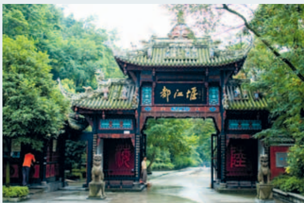
De Dujiang-stuwdam in de Chinese provincie Sichuan werd in 256 v.Chr. aangelegd voor de irrigatie van het omringende land. De constructie zit ingenieus in elkaar, compleet met kunstmatige oever-en-zandwallen die de waterstroom sturen en reguleren. Met zijn 2300 jaar is de dam de oudste nog werkende stuwdam ter wereld.
