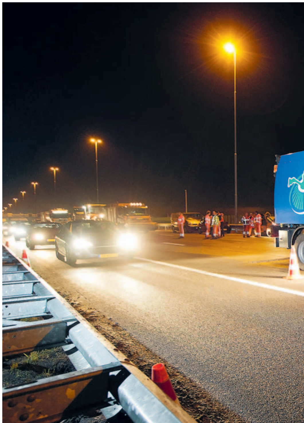
Herstelwerkzaamheden op de A13 bij Rotterdam. 'Het aantal mensen dat op onregelmatige tijden werkt, neemt toe.'
